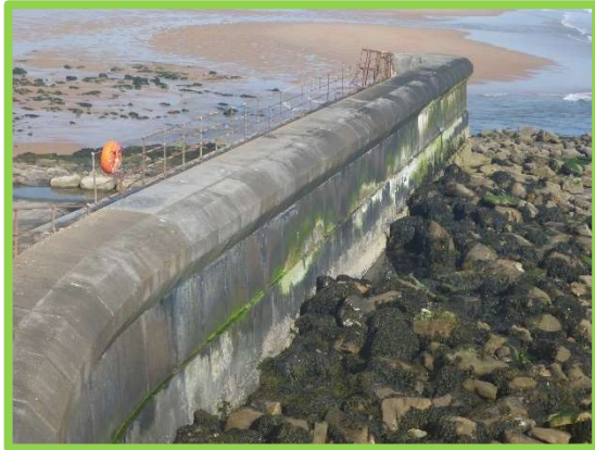
Pier wall (/4401C10)
